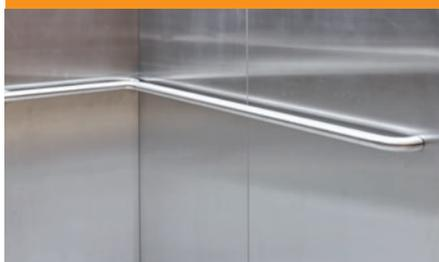
**Aufzugstyp 1, 2 und 3:** Ein durchgängiger Handlauf auf der Seite des Bedientableaus ist verpflichtend. Sollte dadurch die Breite des Kabinenzugangs eingeschränkt sein, darf der Handlauf an der gegenüberliegenden Wand angebracht werden.
